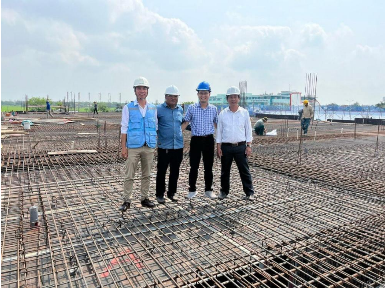
Hình ảnh thi công cốt thép dầm sàn khẩu độ 28m
