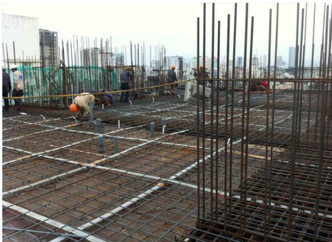
Thi công dầm sàn cáp dự ứng lực
