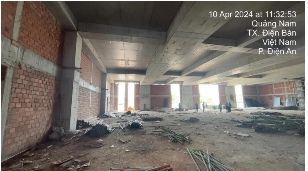
Hình ảnh tháo cốt pha dầm sàn khẩu độ 28m
